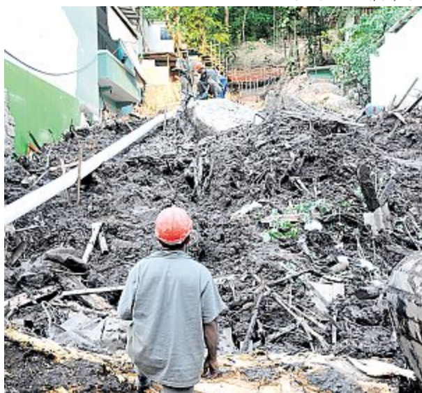
Conclusão dos trabalhos está prevista para outubro
