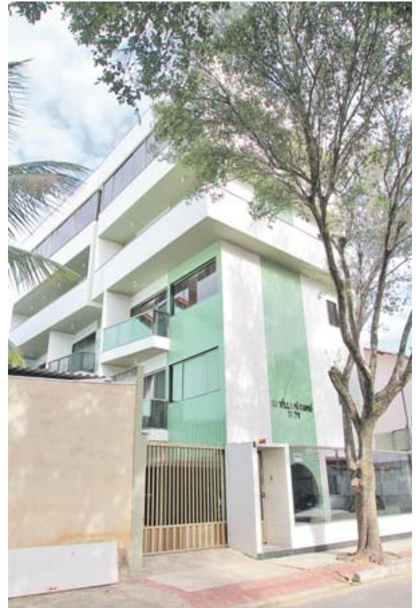
PRÉDIO tem moradores nos andares que devem ser demolidos
