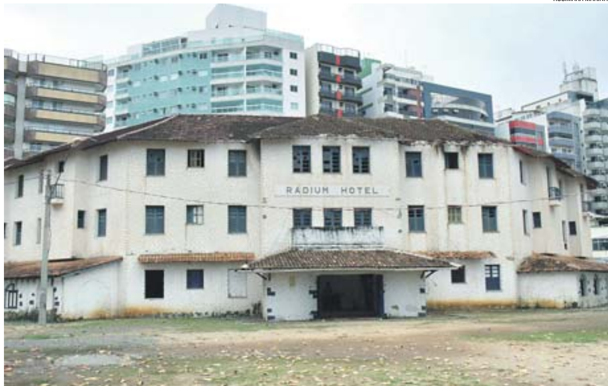
PRÉDIO DO RADIUM HOTEL, tombado como patrimônio afetivo de Guarapari: obras começam até o final do ano
