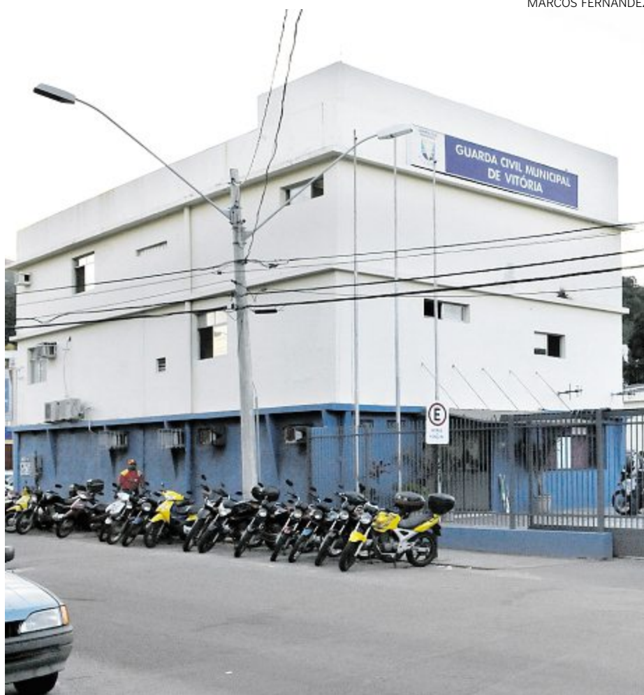
Edifício da Guarda Civil Municipal, na Ilha de Santa Maria, está condenado
