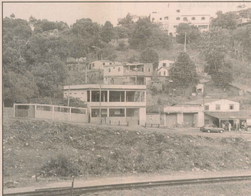
Vista atual do bairro, que não tem esgoto nem ruas pavimentadas
