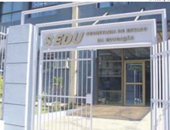
FACHADA DA SEDU: secretaria vai atender cerca de 40 escolas em todo o Estado este ano com obras de manutenção
