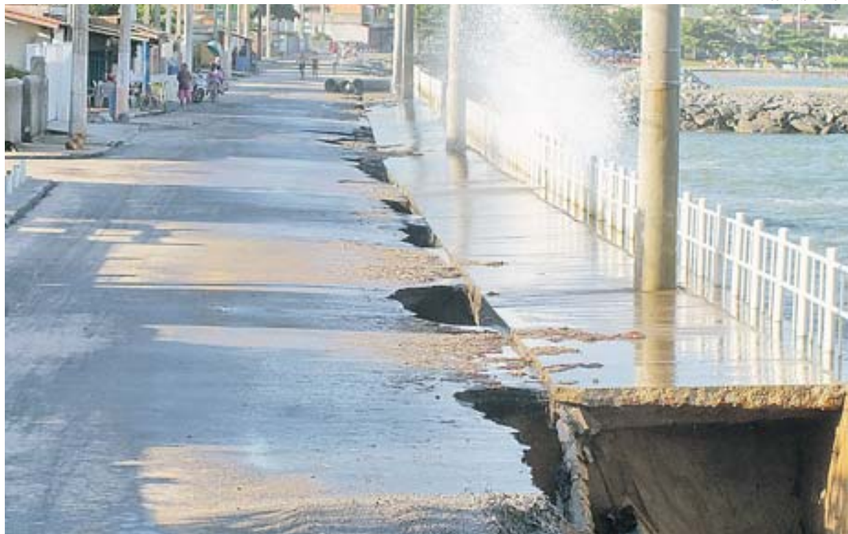
DESTRUIÇÃO causada pela força das ondas na orla de Itaipava, em Itapemirim: faixa de areia será ampliada
