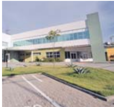
PA DE ALTO LAJE está pronto
