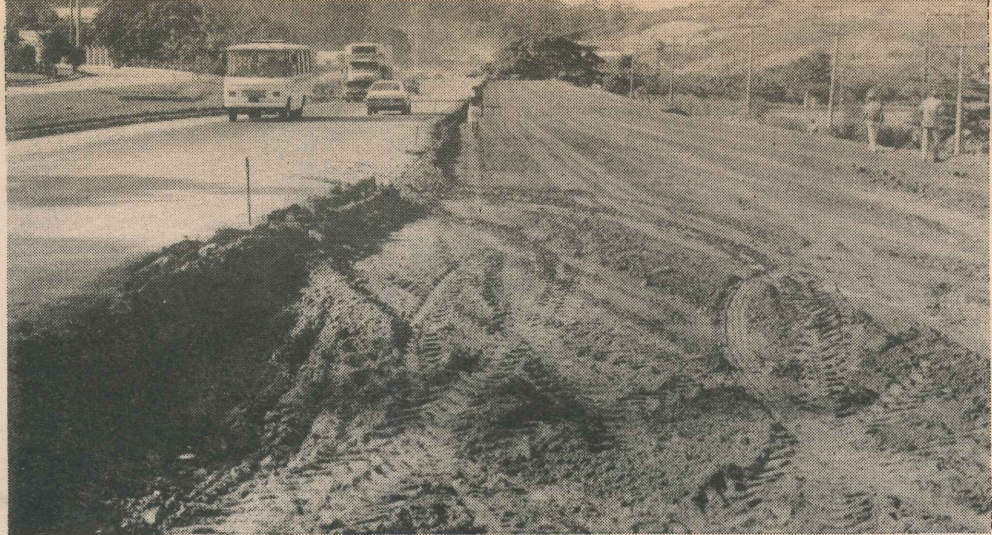
Obras no trecho da BR-262 em Cariacica, que está sendo duplicado
