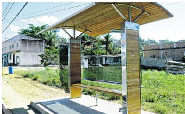
Ponto de ônibus tem estrutura em madeira e aço inox
