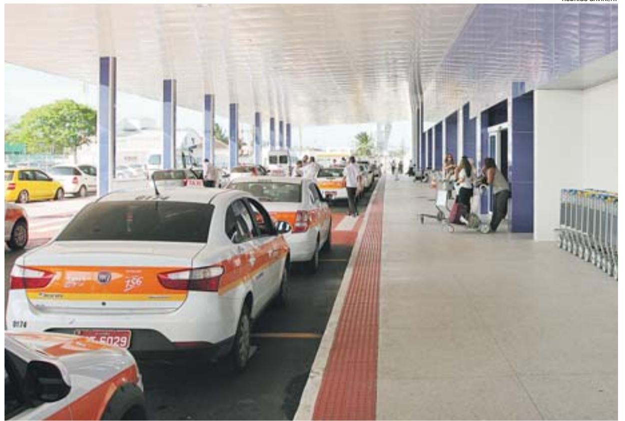
AEROPORTO DE VITÓRIA, cujas obras estão suspensas desde 2008, após irregularidades apontadas pelo TCU
