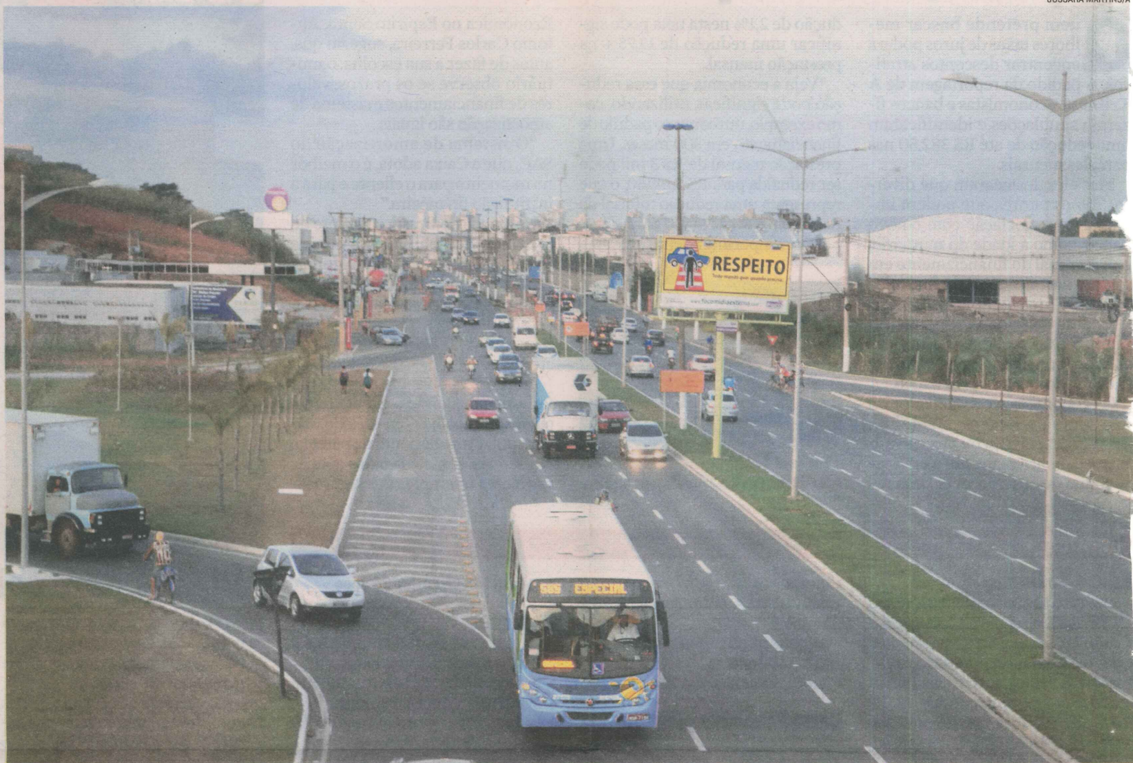
AVENIDA CARLOS LINDENBERG , em Vila Velha, vai passar por novas obras. A via com corredor exclusivo não poderá ter nenhuma adutora embaixo
