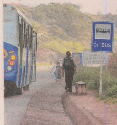
FALTAM baias e abrigos de ônibus. Com isso, passageiros têm de ficar embaixo de sol, chuva e no acostamento.
