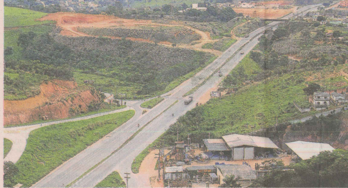
SOLUÇÃO POSSÍVEL. Considerado a Rodovia da Morte, o trecho do Contorno que está em obras ainda representa um risco para o motorista. O cenário muda no trecho que já possui pista dupla
