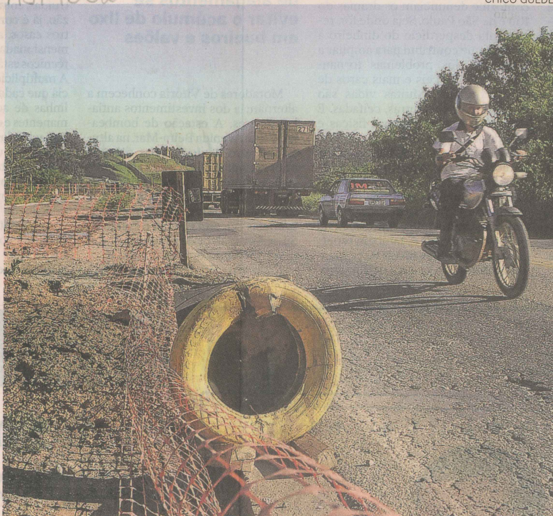
AVISO. Pneus e telas são usados para sinalizar trecho da obra de duplicação do Contorno
