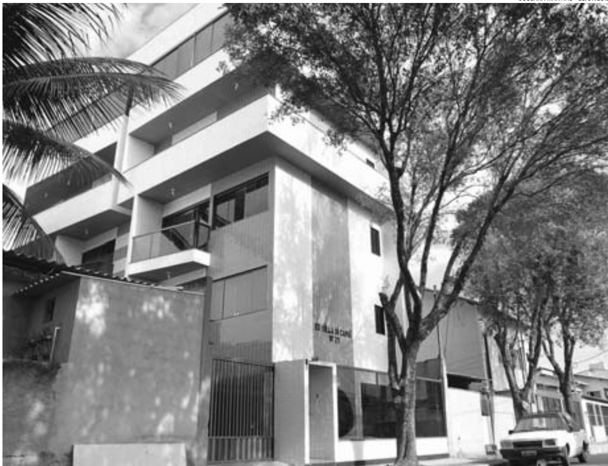
O EDIFÍCIO Villa di Capri terá os três últimos andares demolidos por serem considerados irregulares pela Justiça
