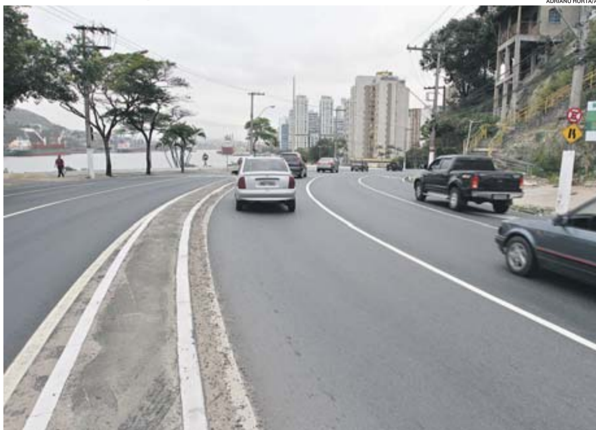
CURVA DO SALDANHA , na Avenida Vitória, onde será construído um viaduto de ligação à avenida Beira-Mar
