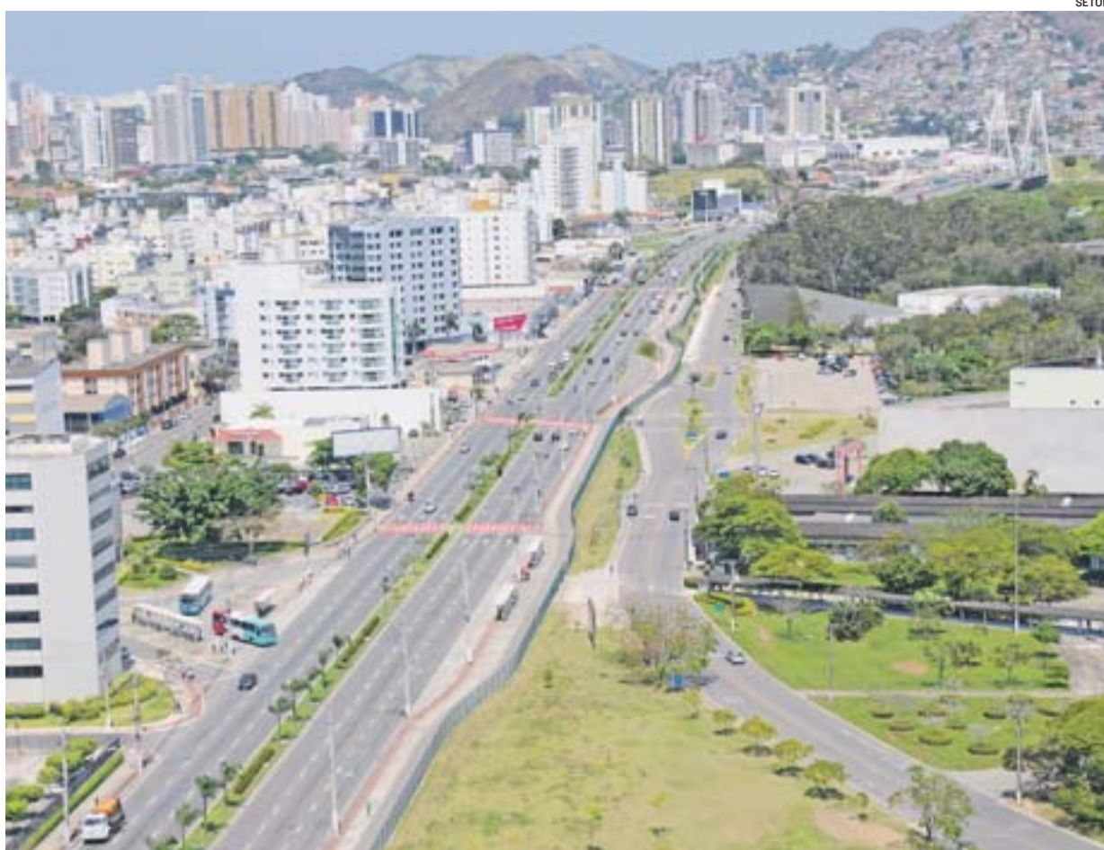
AVENIDA FERNANDO FERRARI: ampliação melhorou o fluxo da via, reduzindo os engarrafamentos
