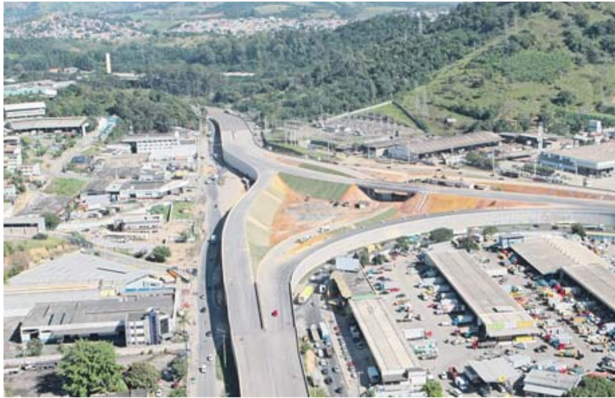
A MAIORIA das empresas de logística instaladas em Cariacica estão localizadas na Rodovia do Contorno
