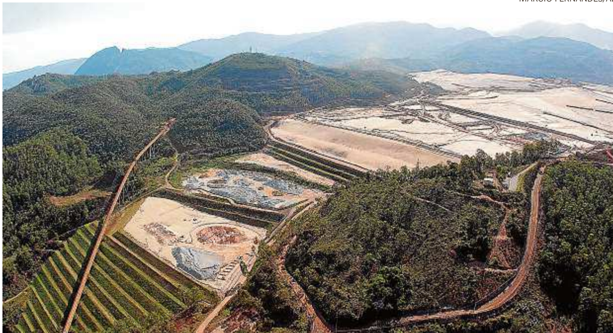
Vista da barragem de Germano, a terceira do parque industrial da Samarco em Mariana e que não se rompeu
