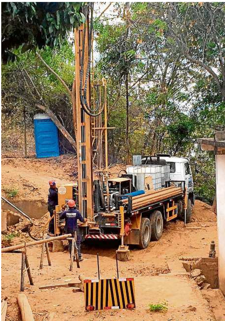
A empresa iniciou trabalhos para captar água de 120 metros de profundidade
