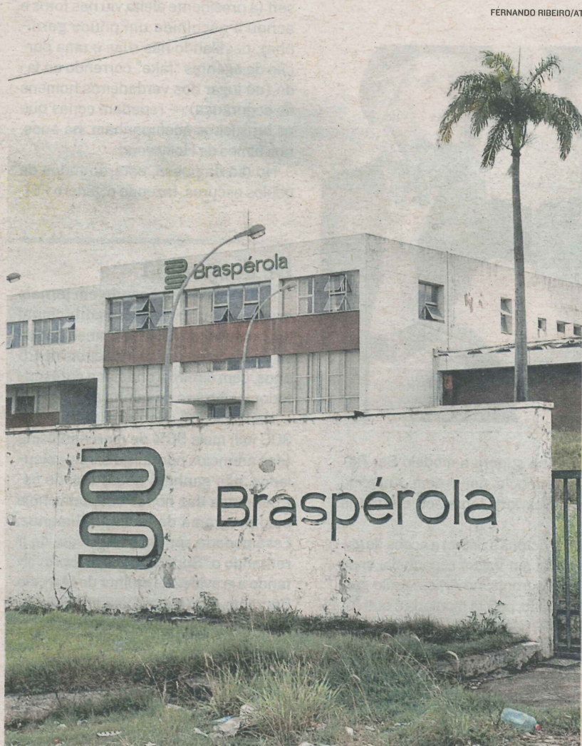
FRENTE DA FÁBRICA, que tem quatro galpões fechados e um semiaberto
