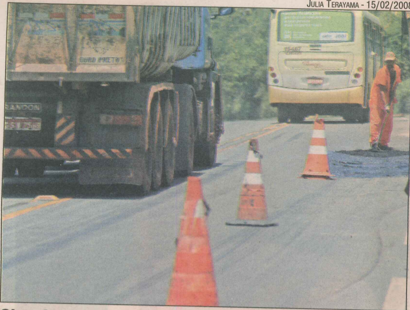
Obra de recuperação na Rodovia do Contorno
