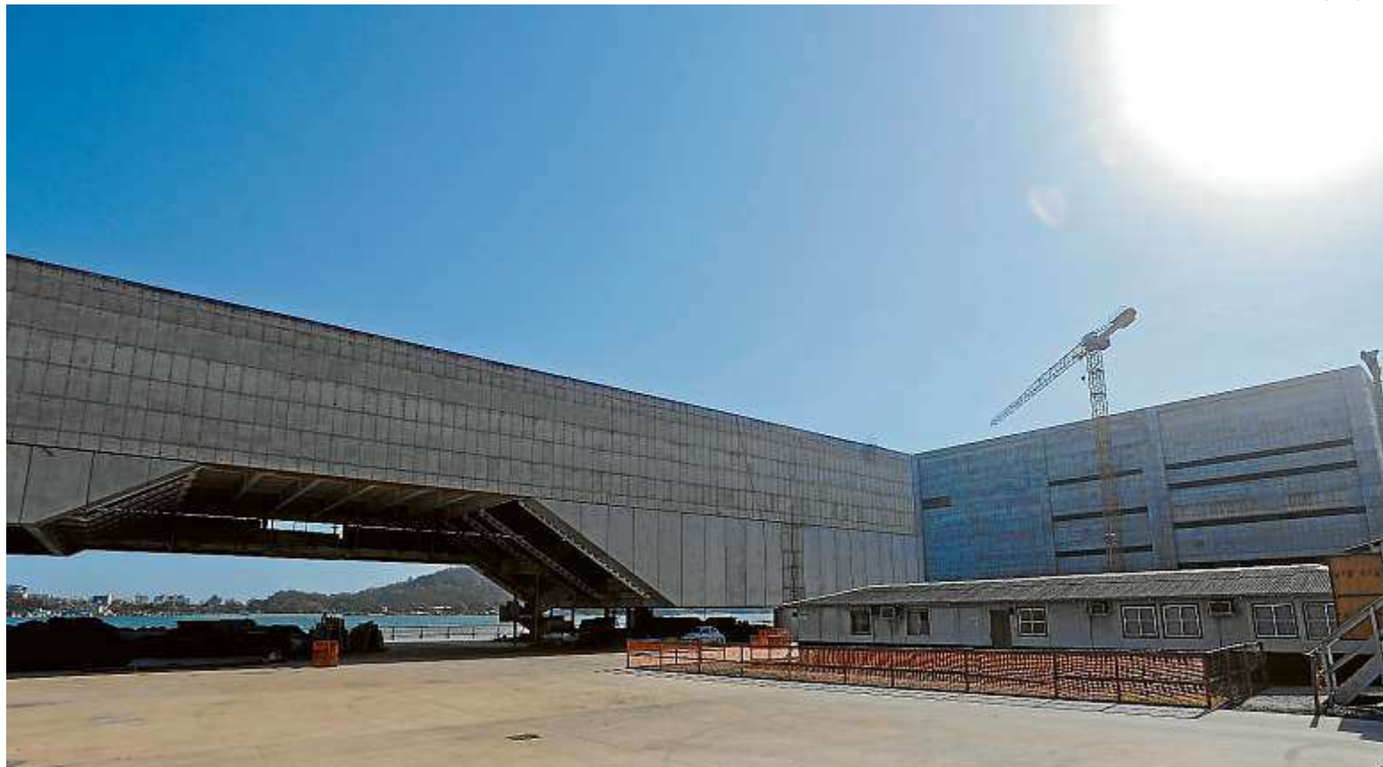
O orçamento inicial para a conclusão do espaço era de R$ 134 milhões. Previsão é de que prédio fique pronto somente em 2018
