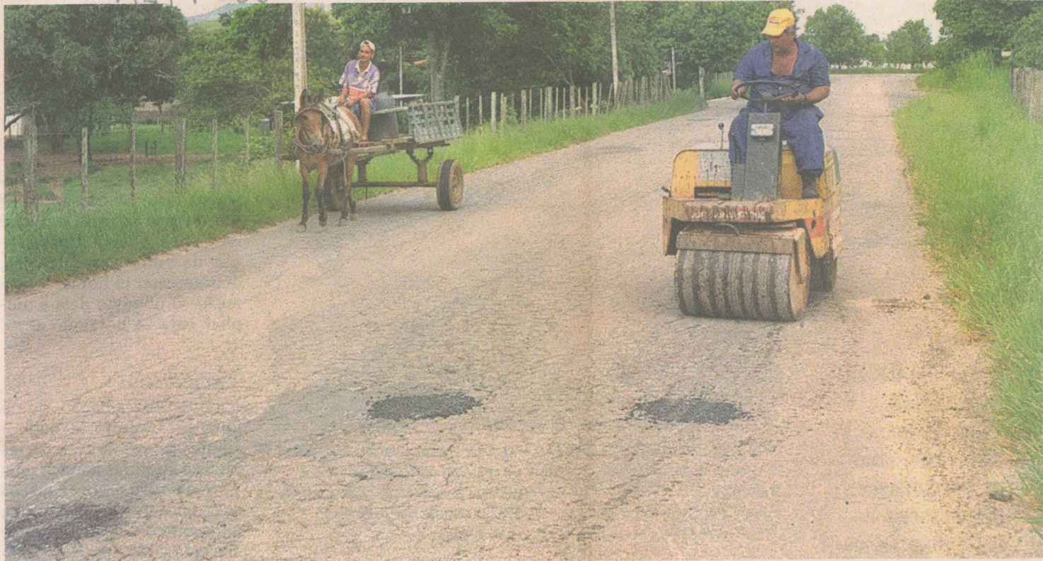
RISCO. Operação tapa-buraco é alternativa de manutenção da ES 080, que liga Cariacica a Santa Leopoldina. FOTO: RICARDO MEDEIROS 20/01/2004
