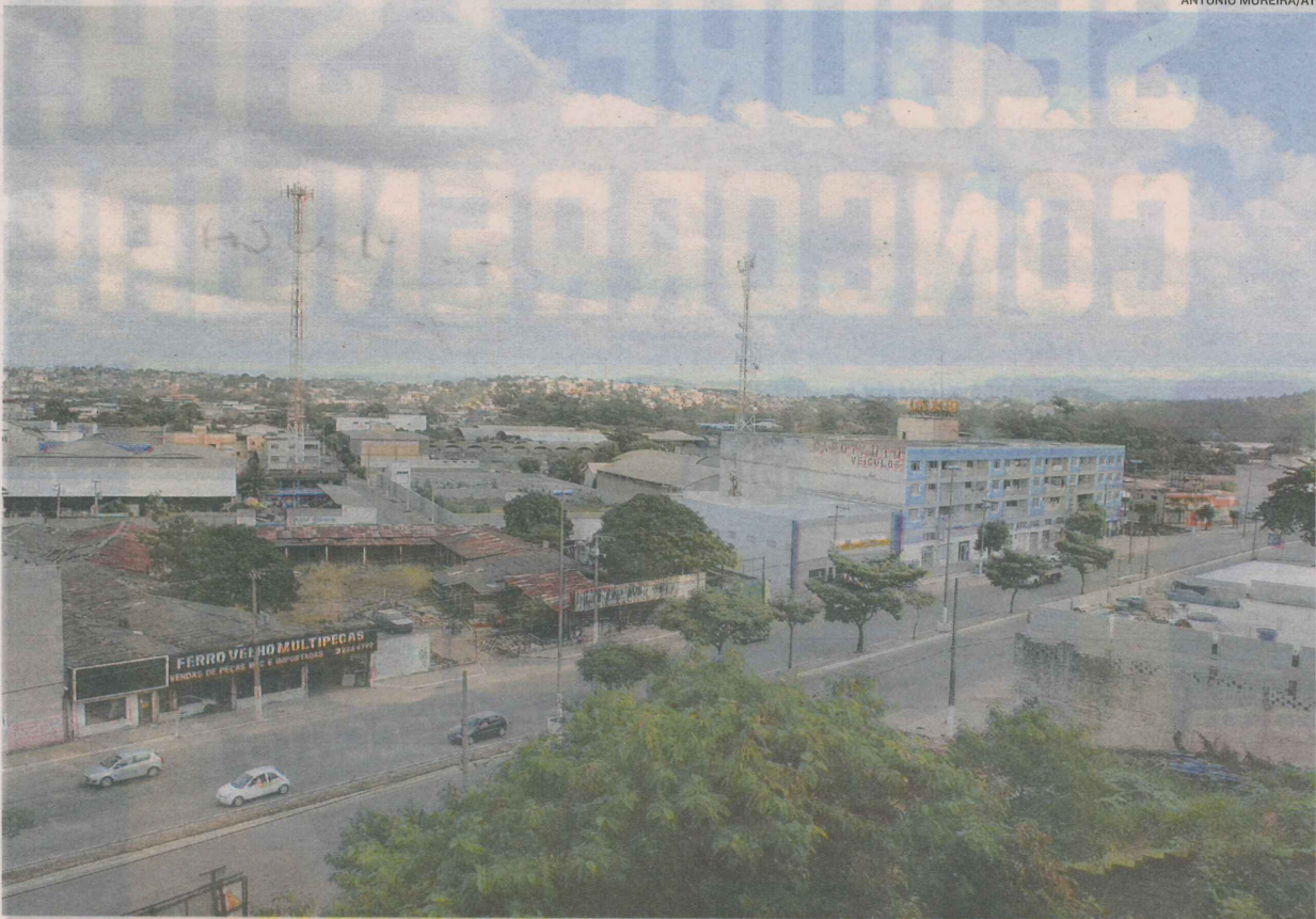
TRECHO DA LINDENBERG, na altura do bairro Cobilândia, onde sairá nova avenida: projeto será elaborado até 2014
