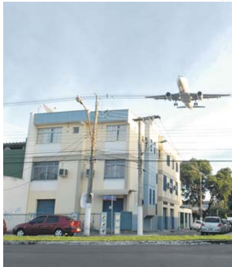
PRÉDIO que, segundo a prefeitura, tem 2,30 metros acima do permitido
