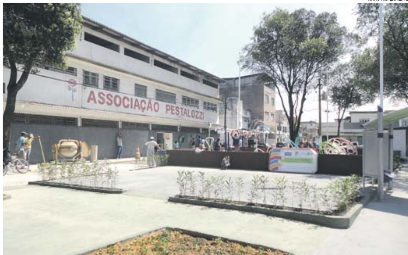
PRAÇA DE SANTA INÊS estava abandonada, mas foi reformada após reivindicação de moradores. Obra custou R$ 80 mil
