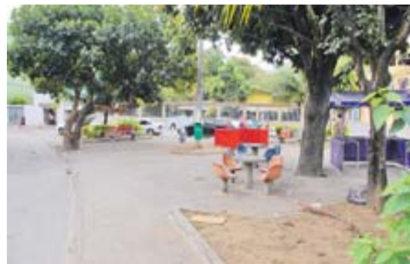
A PRAÇA DE BOA VISTA II, NA SERRA , tem problemas de conservação, possui cadeiras quebradas e falta área de lazer.
