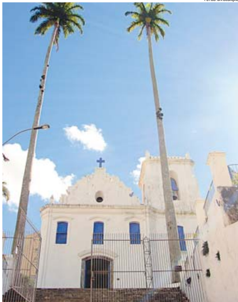
APÓS obras de restauro, a Igreja do Rosário resgatou suas características
