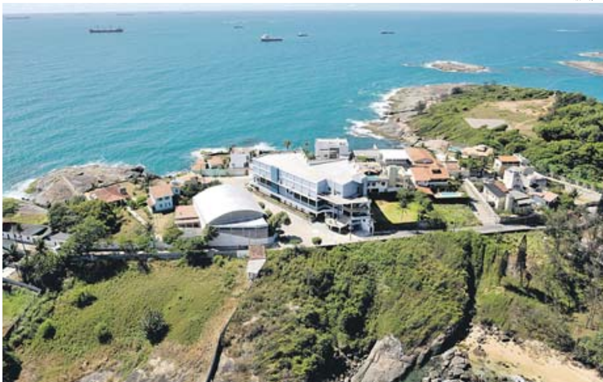
VISTA PANORÂMICA da área da Igreja Missão Praia da Costa: impasse desde 2006 e risco de demolição
