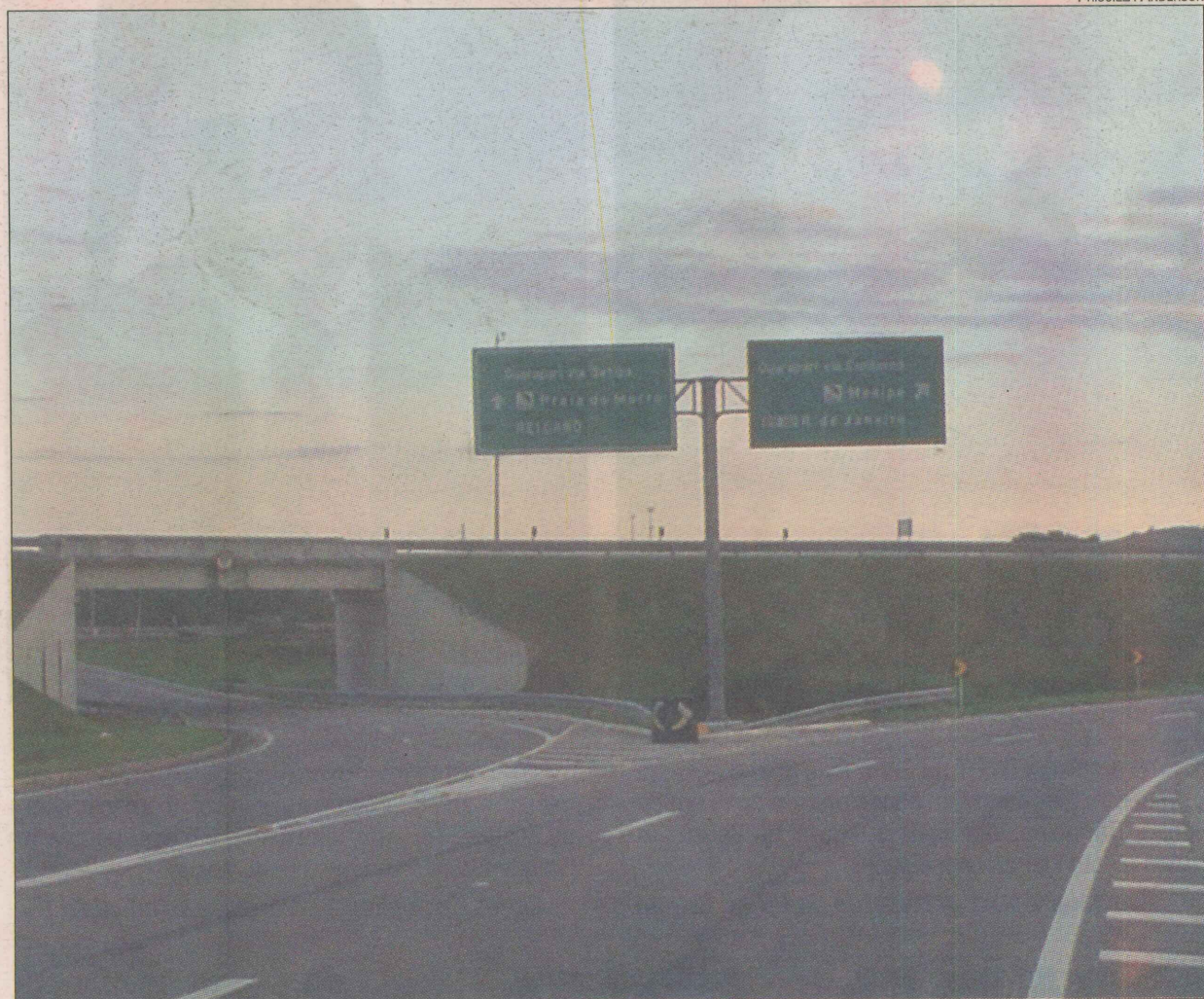
O governo estadual quer preparar a rodovia para a nova fase de crescimento na região
