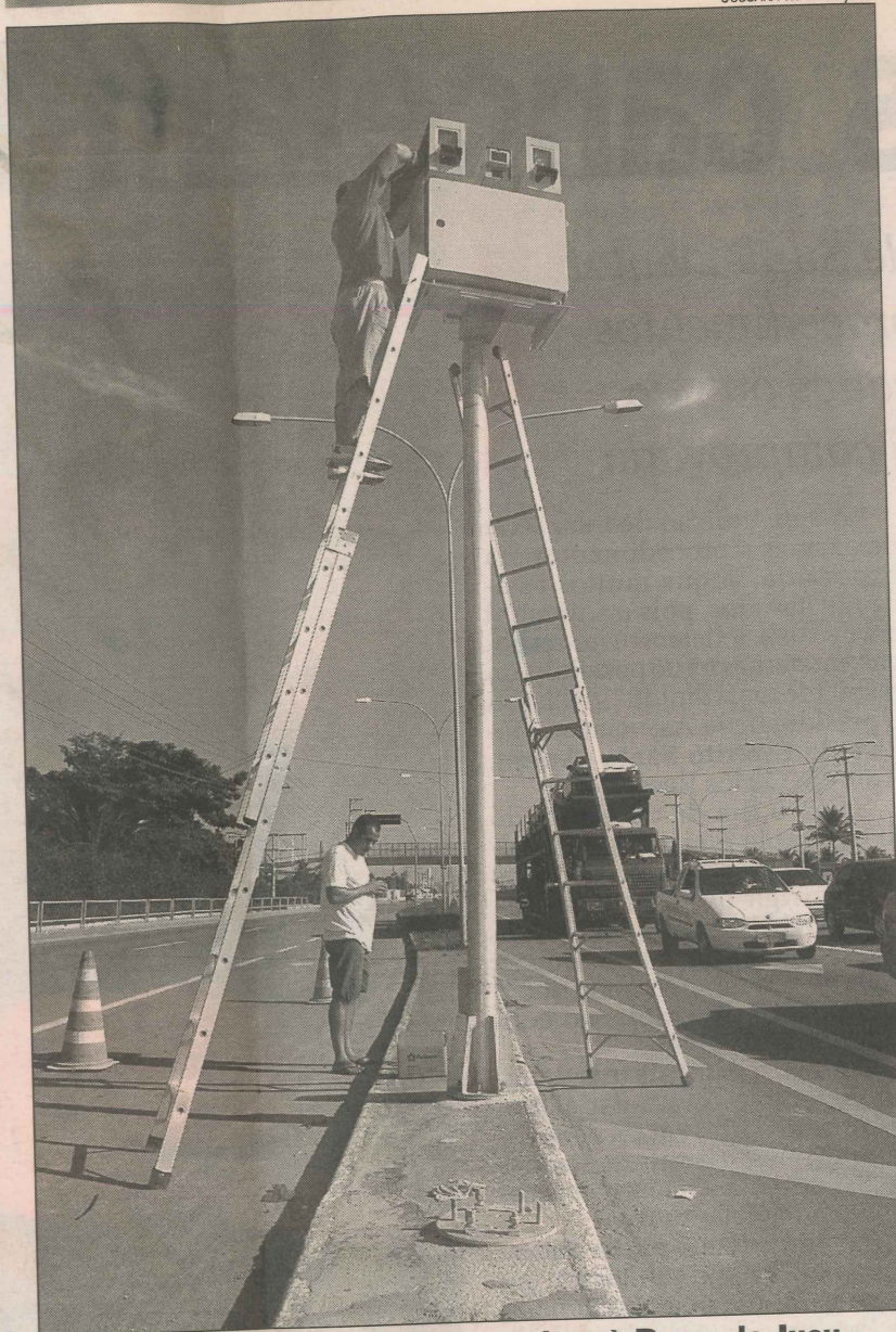
O radar está sendo instalado próximo à Barra do Jucu
