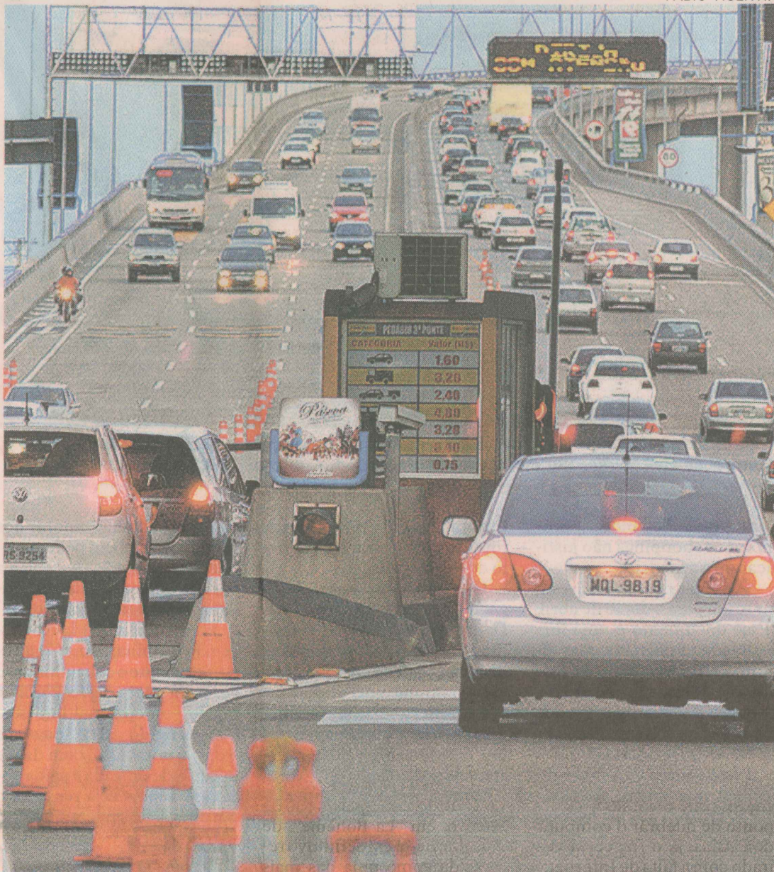
IMPASSE. A decisão de retomar a concessão se deu em razão da insatisfação do governo com a alegação da empresa de que não dispõe de condições para realizar obras nos acessos à ponte
