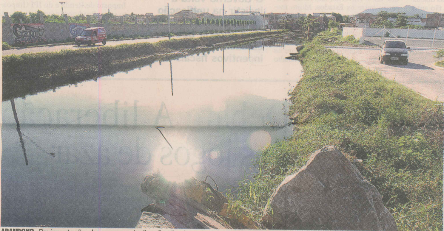
ABANDONO. Pavimentação, drenagem e sinalização são algumas das intervenções a serem feitas no canal. FOTO: CARLOS ALBERTO DA SILVA
