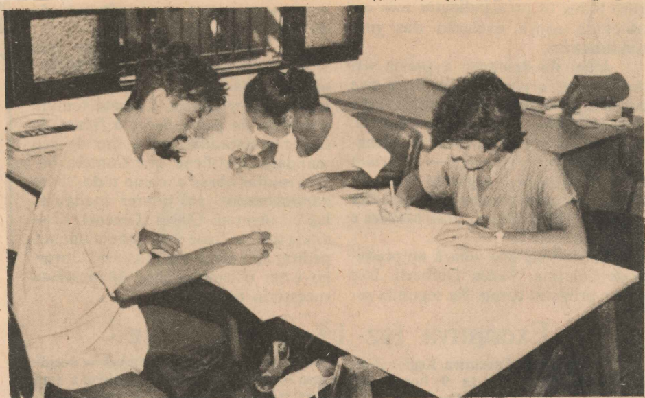
Técnicos do Aglurb vão fixar os locais onde serão construídos os terminais
