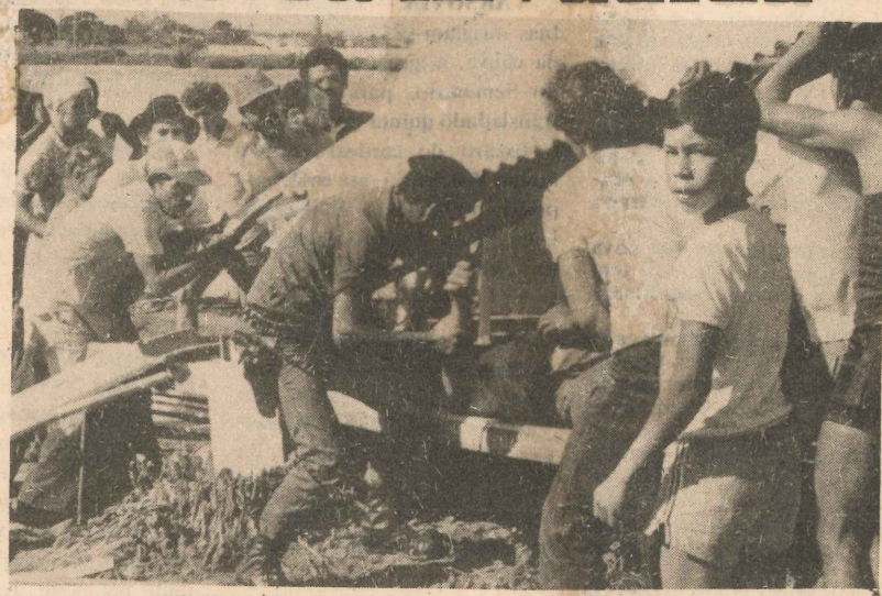
Mulher fica presa nos escombros da casa e...
