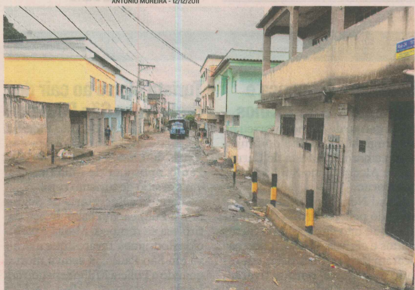
A RUA 24 vai ser pavimentada em Nova Rosa da Penha, Cariacica
