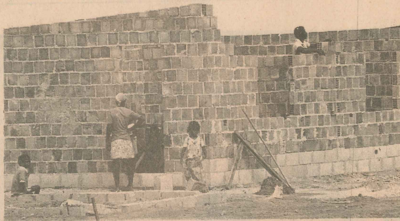
As casas de alvenaria e de madeira são erguidas rapidamente no Vale
