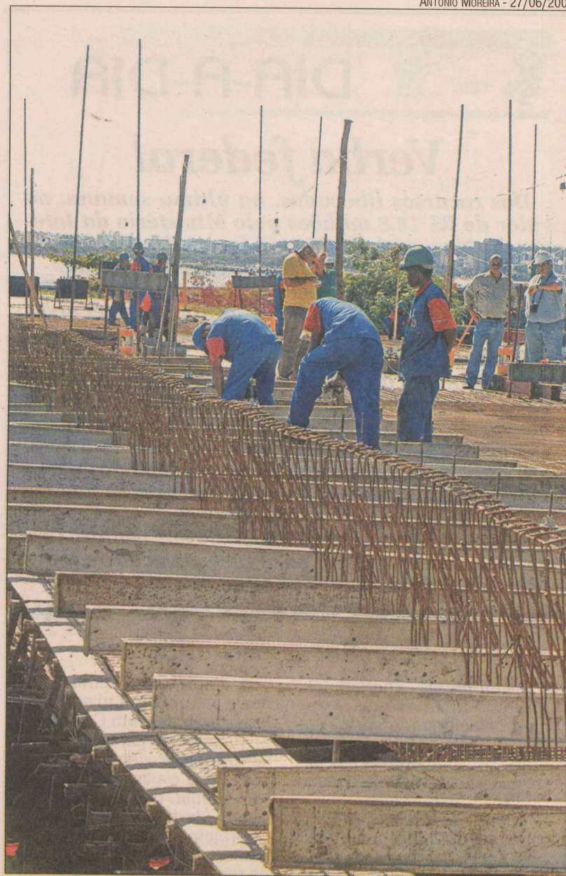
Obra na Ponte de Camburi, em Vitória: segunda no ranking
