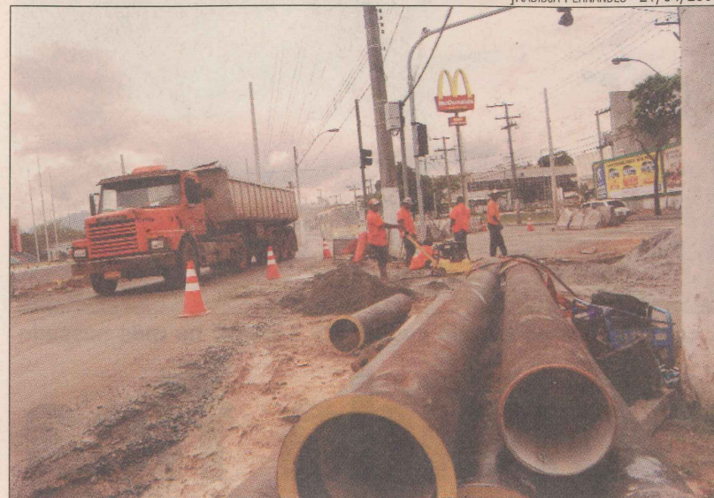
Obras de saneamento em avenida: meta é ampliar rede de esgoto
