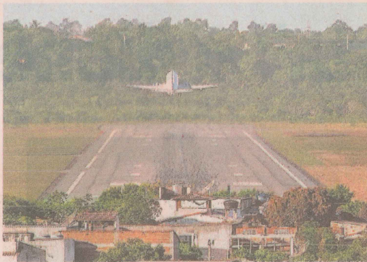
PRESENTE. Aeroporto: obras estão paradas e há a sugestão de construção de terminal fora de Vitória. FOTO: GABRIEL LORDELLO
