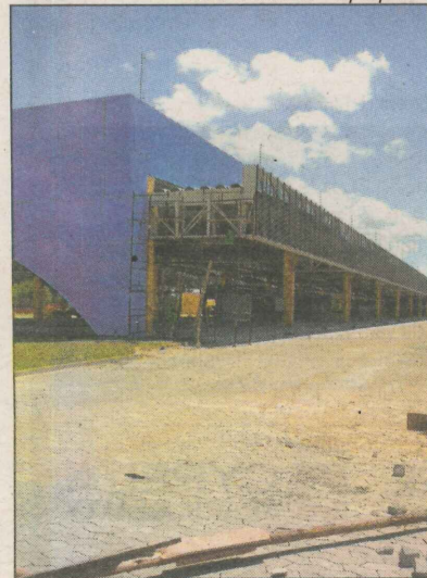
Obra do Terminal de Itaparica
