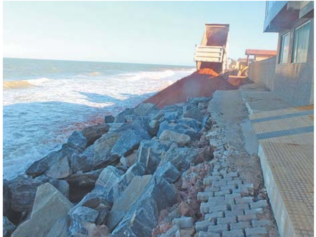
MURO DE CASA na Praia da Lagoa Funda desabou devido à erosão: máquinas jogam terra para evitar mais destruição
