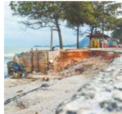
MURO DE CASA na Praia da Lagoa Funda desabou devido à erosão: máquinas jogam terra para evitar mais destruição
