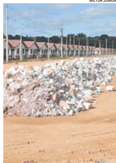
LINHARES: obras de proteção
