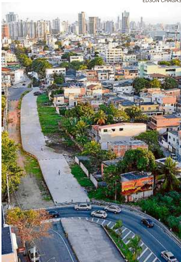
Obra de prolongamento do Canal Bigosse não evoluiu
