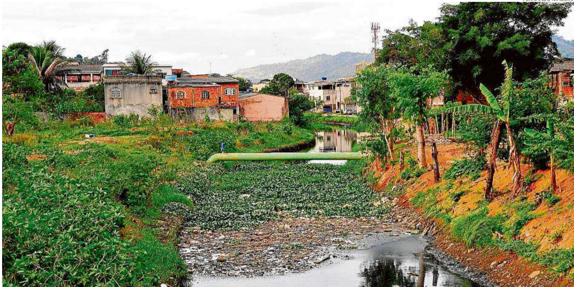
Obras de canalização de afluentes do Rio Itanguá, em Cariacica, começaram em 2008, pararam um ano depois e até hoje não foram retomadas pela prefeitura
