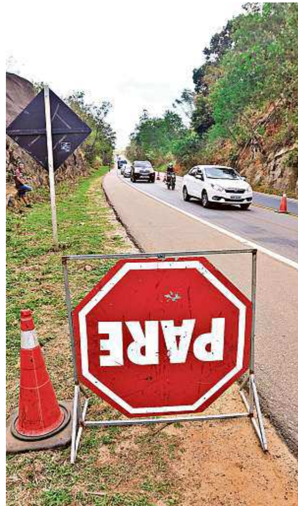
Trecho da BR 101 em Fundão, com obras de duplicação
