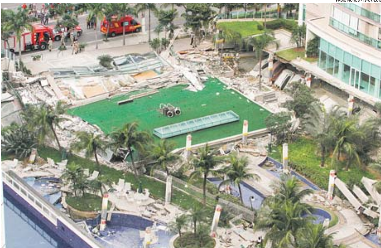
ÁREA DE LAZER do condomínio na Enseada do Suá desabou sobre as garagens, deixando um morto e cinco feridos
