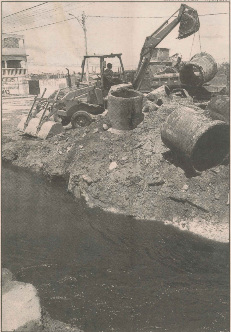
Entulhos são retirados de um canal em Terra Vermelha
