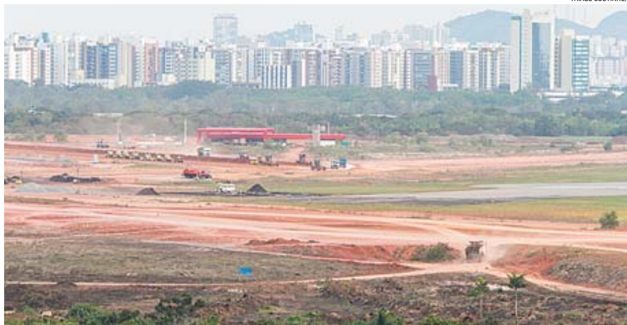
AEROPORTO DE VITÓRIA já teve 30% das obras concluídas, segundo a empresa responsável
