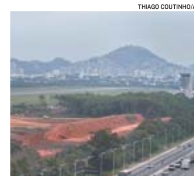
OBRAS no aeroporto de Vitória
