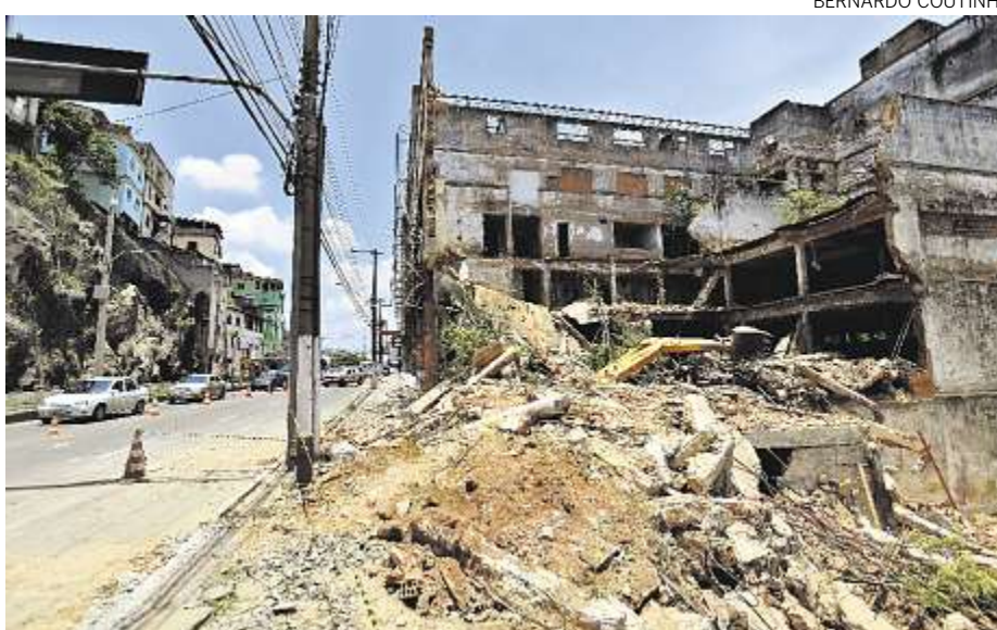
Uma retroescavadeira subiu numa laje, que não suportou o peso e cedeu
